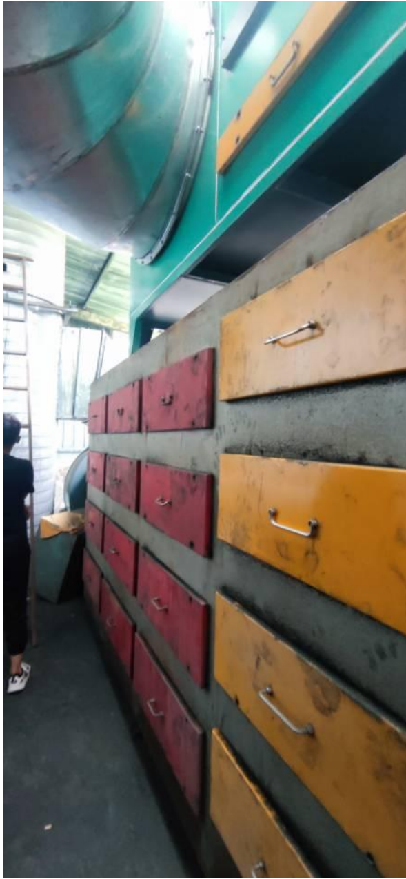
喷漆废气处理设施
