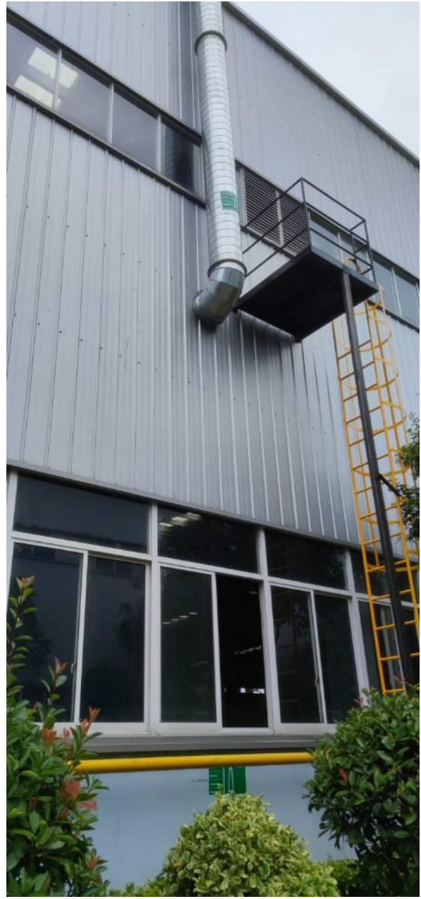
喷塑烘干废气排气筒及标识牌
