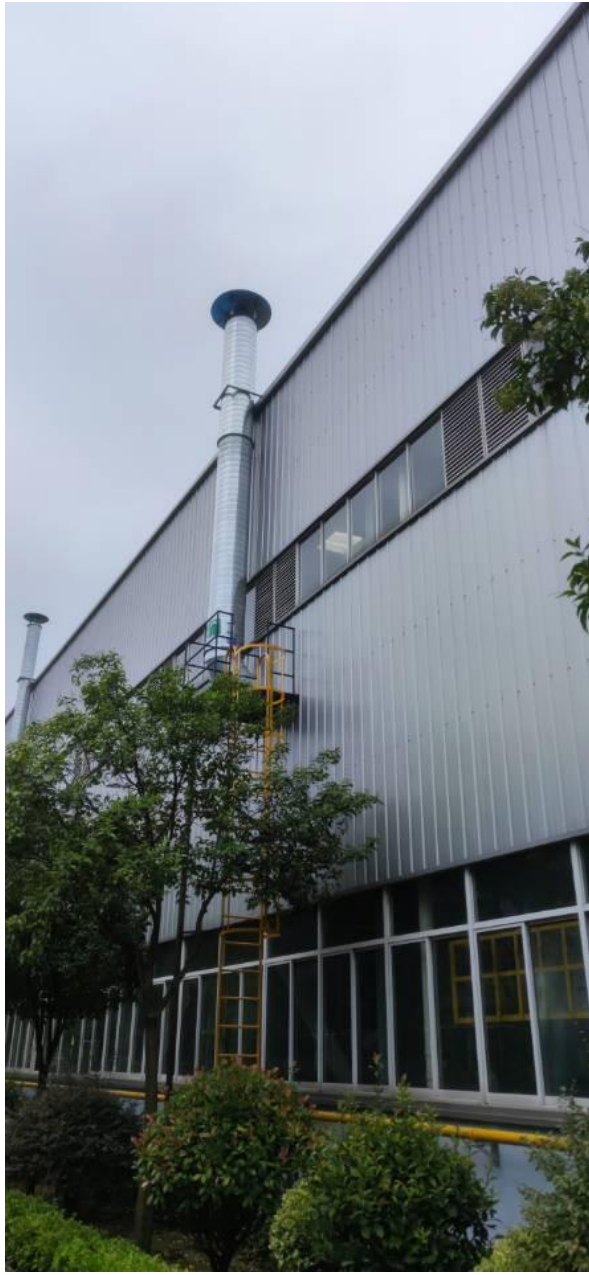
喷塑废气排气筒及标识牌
