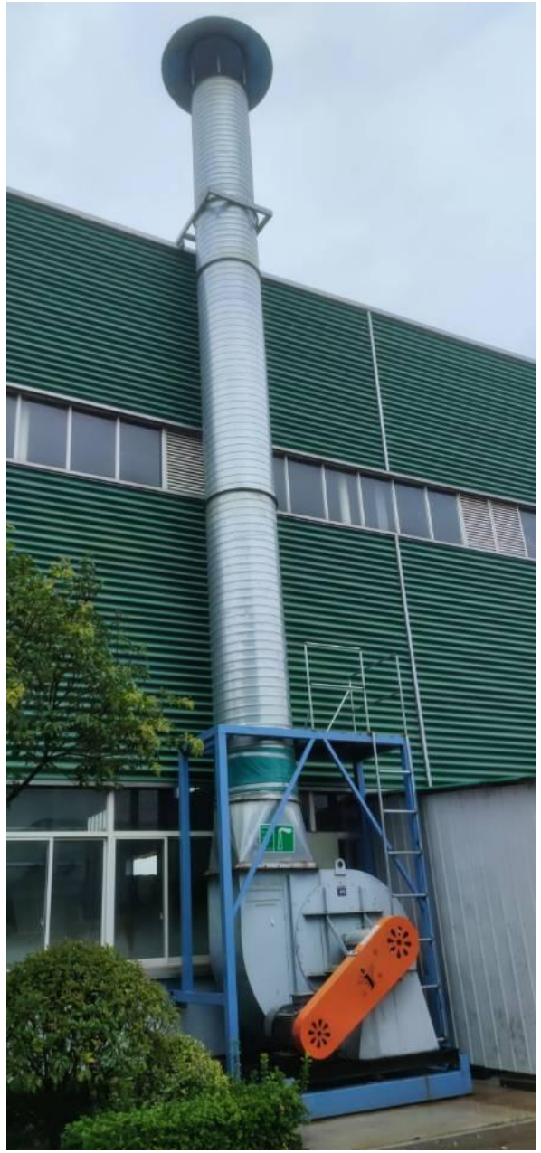
抛丸粉尘废气排气筒及标识牌
