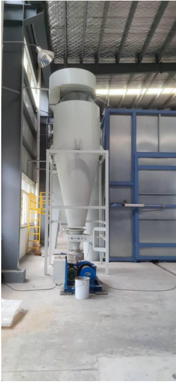
抛丸粉尘废气处理设施
